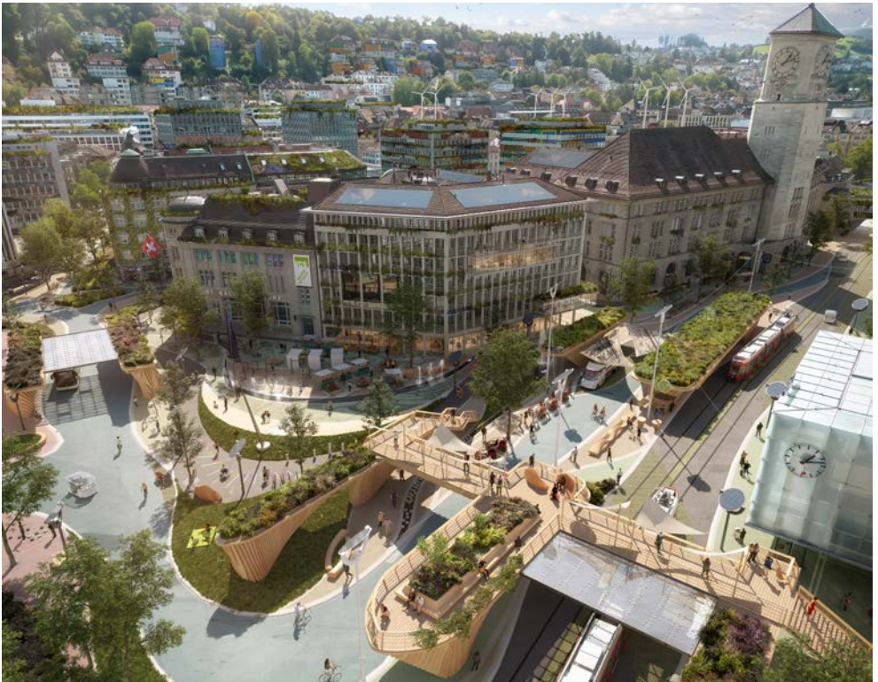
Abb. 1 Seite 54/55: Zürich Paradeplatz, Zukunftsbilder 2045 (Quelle: Reinventing Society & Wire Collective, Ursprungsfoto: Denese Grebin)
